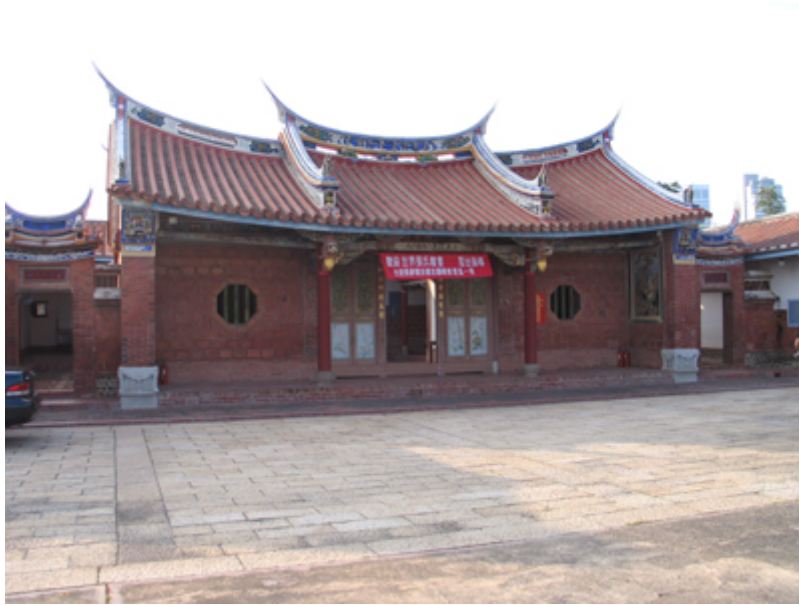
台中市西屯區三級古跡傳統宗祠 紅磚瓦木造結構張家祖廟外觀
